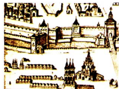
Фрагмент карты Москвы с изображением зданий Мытного двора и Большой Московской таможни. XVIII в.
