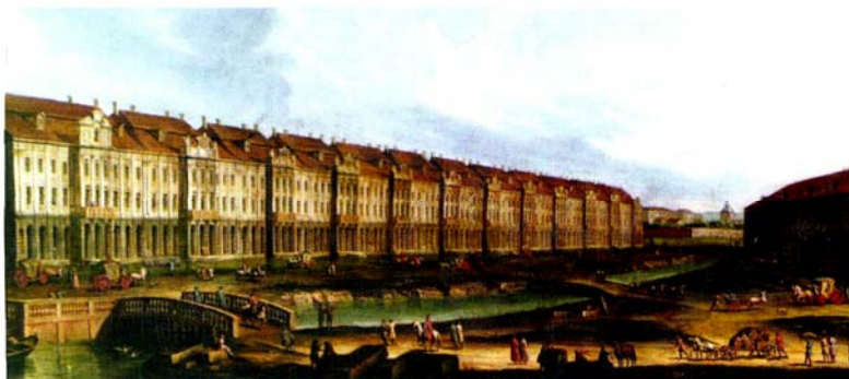
Здание Двенадцати Коллежий с частью Гостиного Двора. г. Санкт-Петербург. 1753 г.
