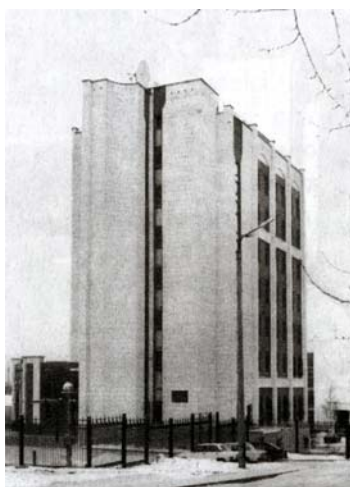
Строительство нового здания Архангельской таможни было завершено 14 декабря 1994 г.
